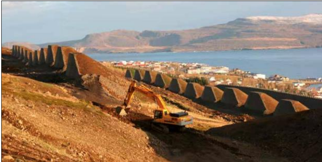
Mynd 5.1 Í Neskaupsstað eru sambærilegar keilur og fyrirhugaðar eru á Seyðisfirði, en í þessu verkefni verða aðeins byggðar 7 keilur.
